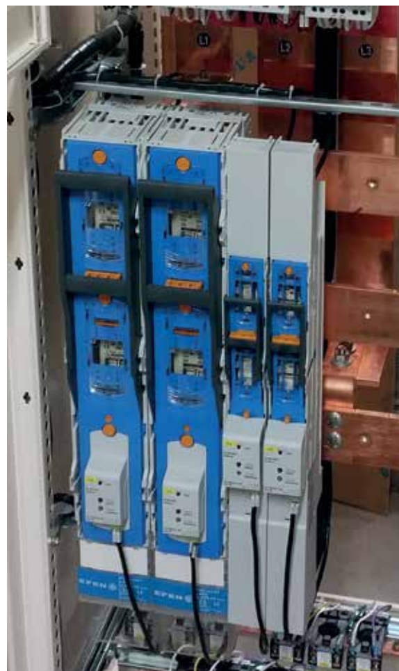
7.8. Пример разъединителей с электронной системой мониторинга предохранителей, примененных в промышленных установках.
