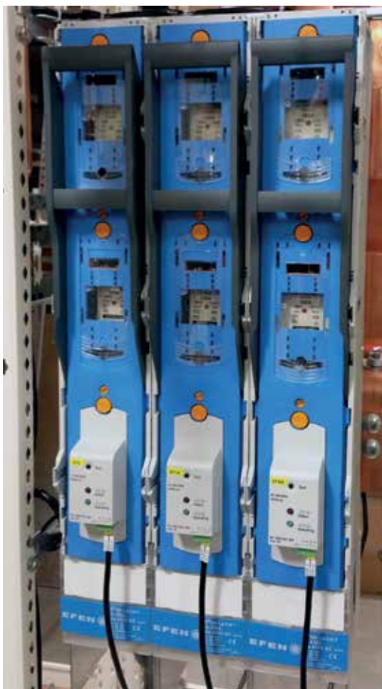
7.8. Пример разъединителей с электронной системой мониторинга предохранителей, примененных в промышленных установках.
