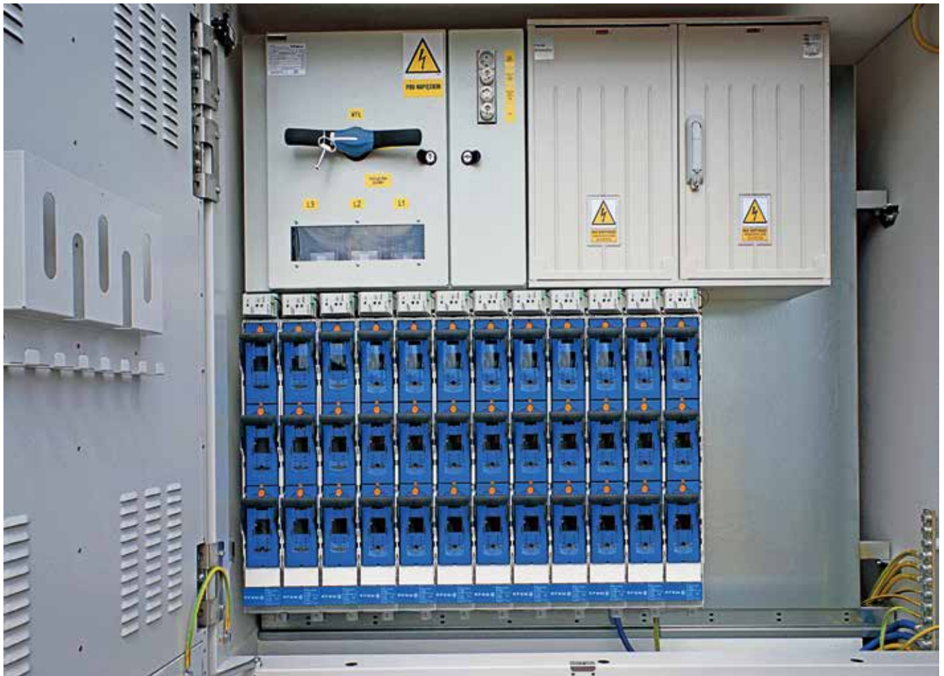
15. Пример разъединителей NSL E3 с электронной системой мониторинга предохранителей в установке производства PKI WILK.
