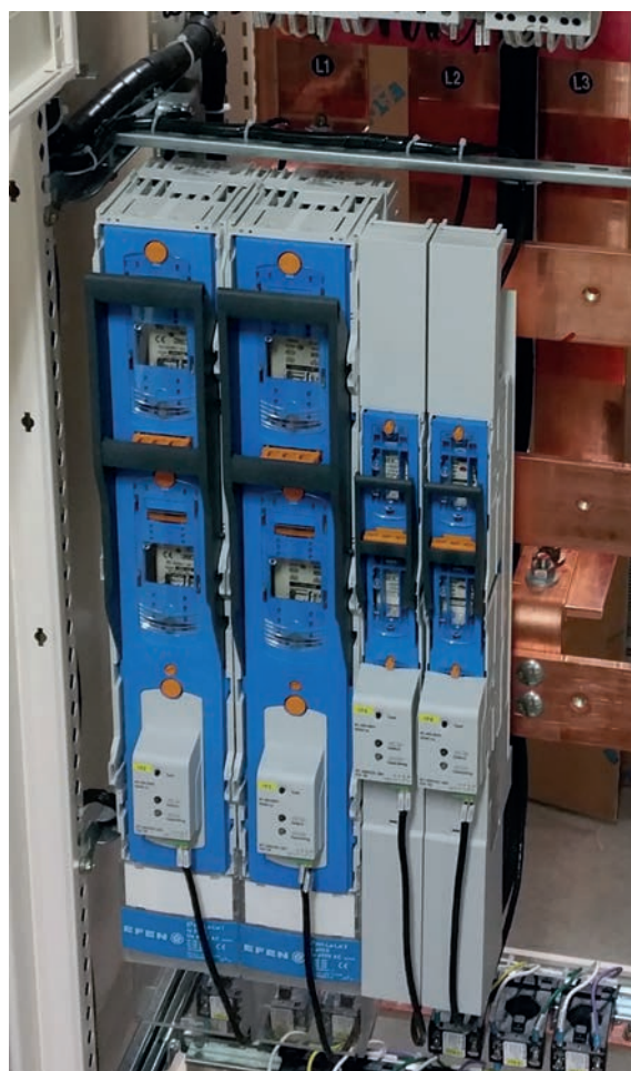
Zdj. 7,8. Przykład rozłączników bezpiecznikowych z kontrolą przepalenia wkładek bezpiecznikowych zastosowanych w rozdzielniach dla przemysłu
