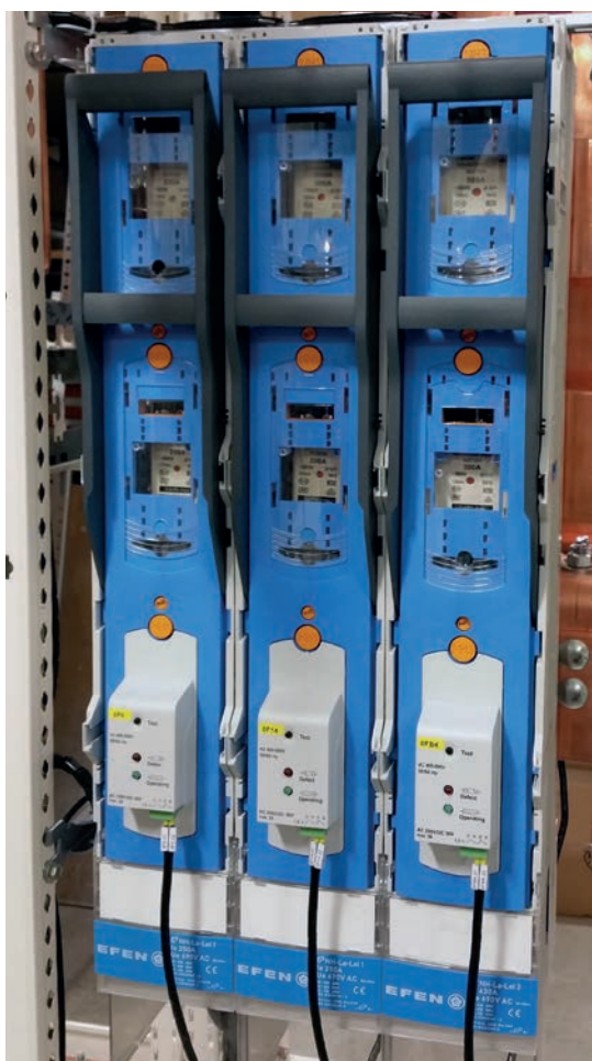
Zdj. 7,8. Przykład rozłączników bezpiecznikowych z kontrolą przepalenia wkładek bezpiecznikowych zastosowanych w rozdzielniach dla przemysłu
