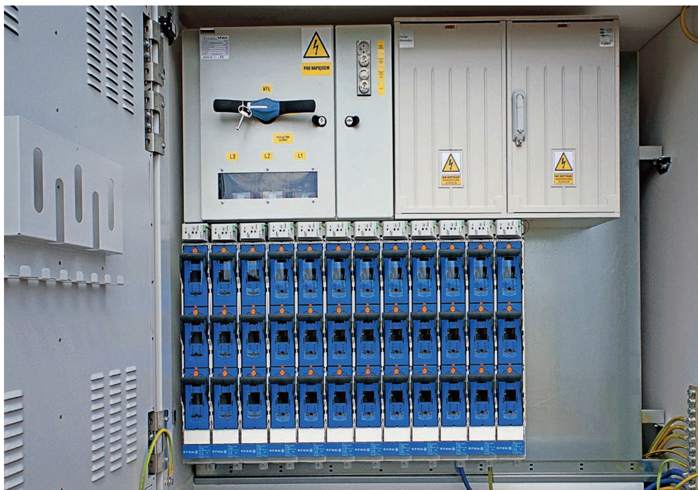
Zdj. 21. Przykład rozłączników bezpiecznikowych NSL E3 z kontrolą przepalenia wkładek bezpiecznikowych w stacji transformatorowej produkcji PKI WILK
